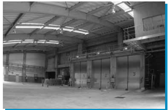
焼却施設プラットフォーム
